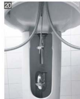
洗面器をペDESTALの上ののせます。
