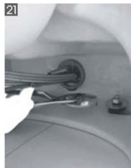
ワッシャーとナットをはめ、器具にて固く固定します。
