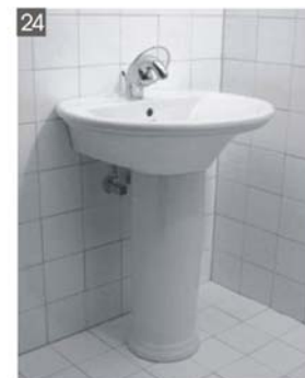
完成です。漏水がないかご確認ください。
