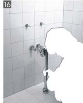
ストラップを床排水管と接続します。※配管工事と洗面器設置工事が別手配の場合は、洗面器設置後でも施工可能です。
