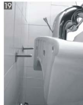
アンカーボルトを洗面器の背面の孔に挿入します。
