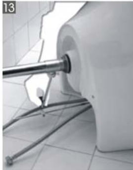
レバー式のポップアップの場合、水平棒にクリップの片側をはめます。
